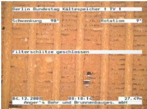
Abb. 10: Filter von KS-1 vor Regenerierung 2008
